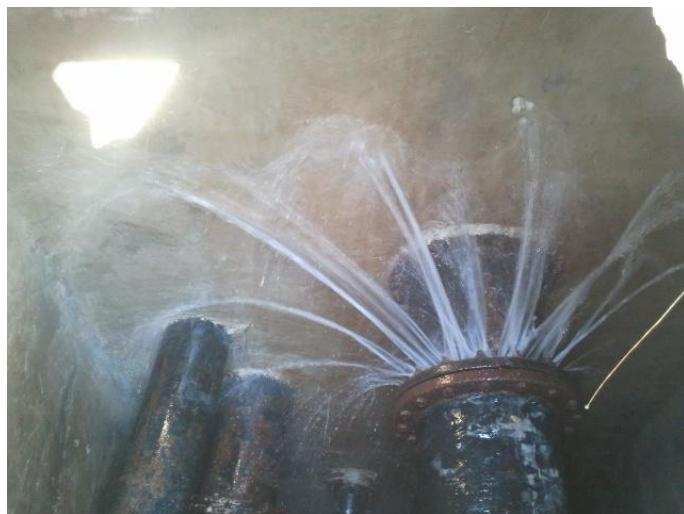
*Slika 1 – Curenje na transportnoj cijevi (Vodovodni sistem Travnik)*
