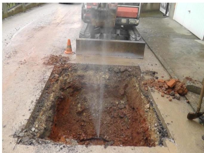
*Slika 5 – Podzemno curenje otkriveno zvučnom detekcijom (Vodovodni sistem Tuzla)*
