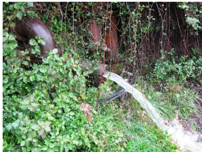
*Slika 3 – Curenje na prelivu iz rezervoara (Vodovodni sistem Cetinje – Republika Crna Gora)*
